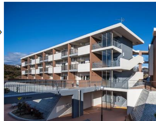
災害公営住宅
